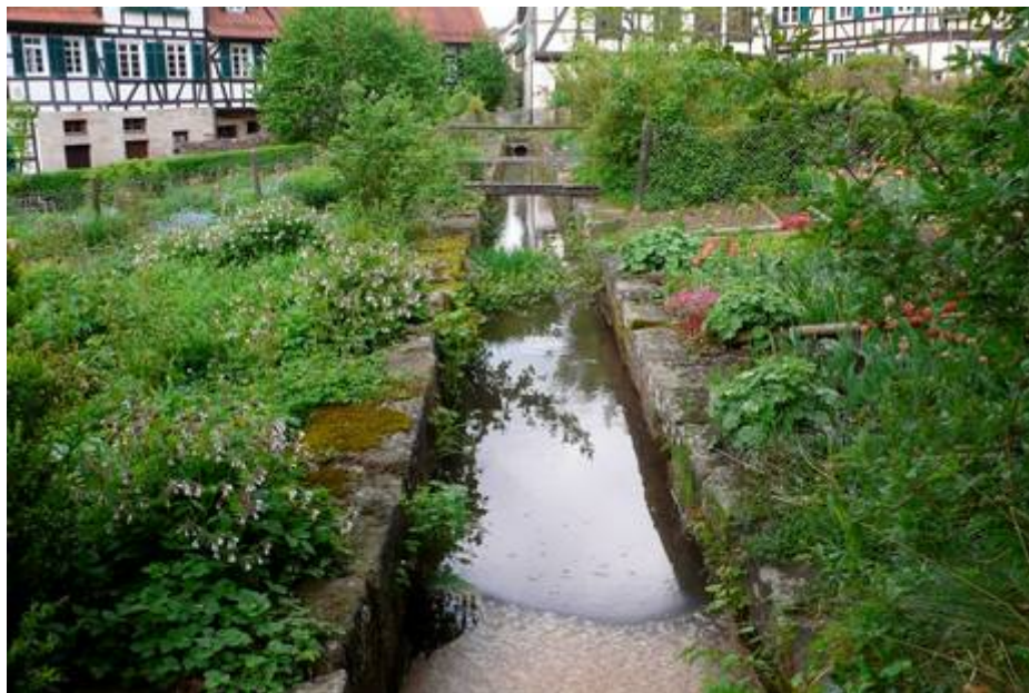
Abbildung 2.1: Teilstück des Mühlkanals in Bebenhausen
