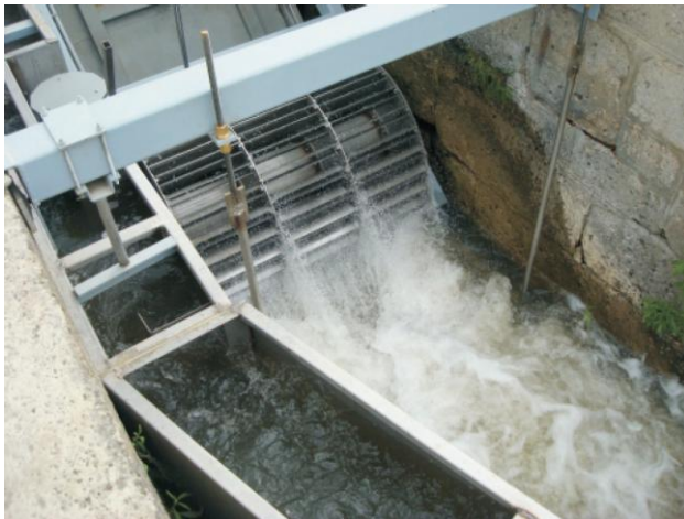
Abbildung 12: Lamellenturbine (Quelle: http://www.bew-power.at )
