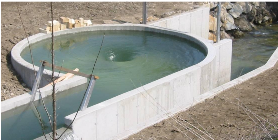
Abbildung 11: Wasserwirbelkraftwerk. (Quelle: http://www.zotloeterer.com )
